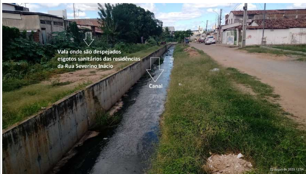
Foto 01: Rua José Marlon Alves Amaro, Bairro Noé Trajano, Patos/PB. Esgotos sanitários residenciais ligados ao canal e à vala aberta. 22/06/2023.
