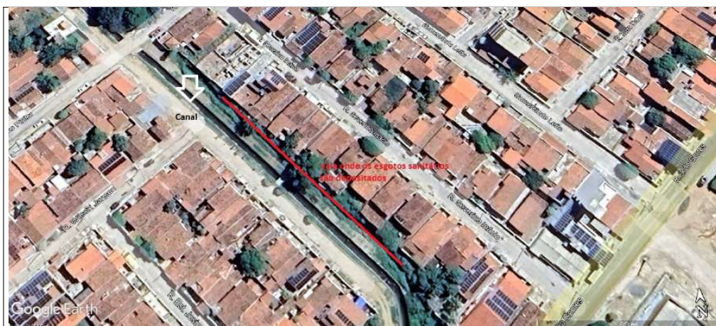
Imagem 02: Rua José Marlon Alves Amaro, Bairro Noé Trajano, Patos/PB. Esgotos sanitários residenciais ligados ao canal e à vala aberta. 22/06/2023.
