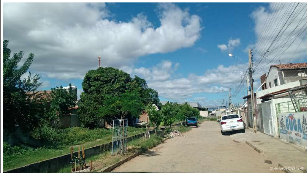
Foto 03: Rua José Marlon Alves Amaro, Bairro Noé Trajano, Patos/PB. Esgotos sanitários residenciais ligados ao canal. 22/06/2023.
