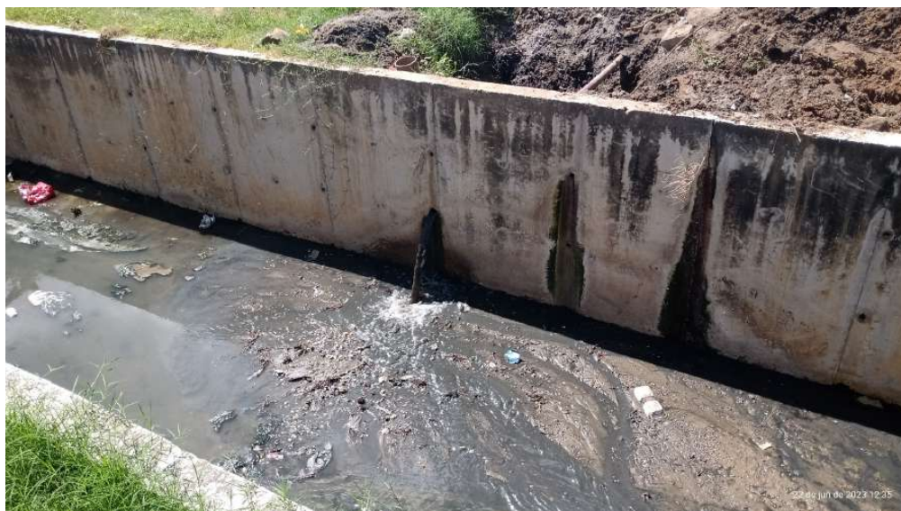
Foto 08: Rua José Marlon Alves Amaro, Bairro Noé Trajano, Patos/PB. Esgotos sanitários residenciais ligados ao canal. Despejos indevidos de efluentes. 22/06/2023.
